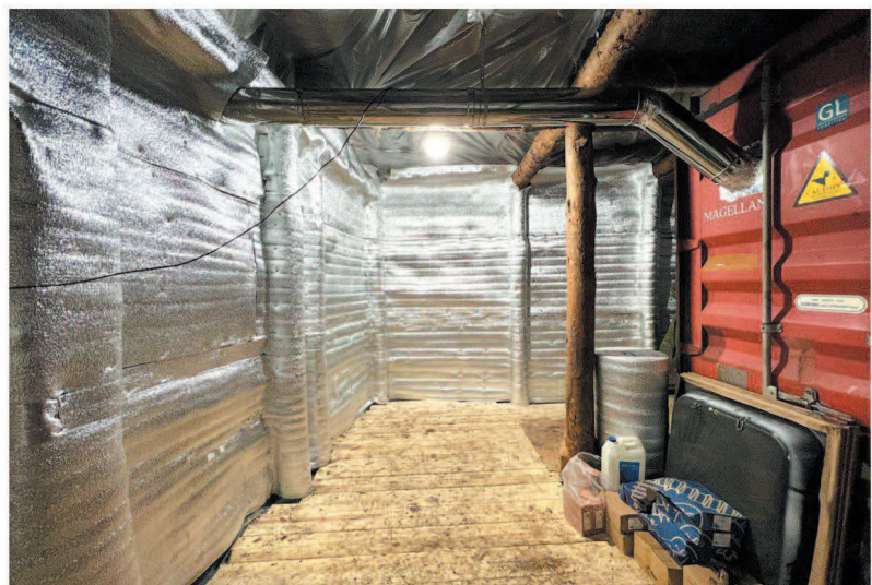
Так сейчас выглядят стены подземного ФАПа
